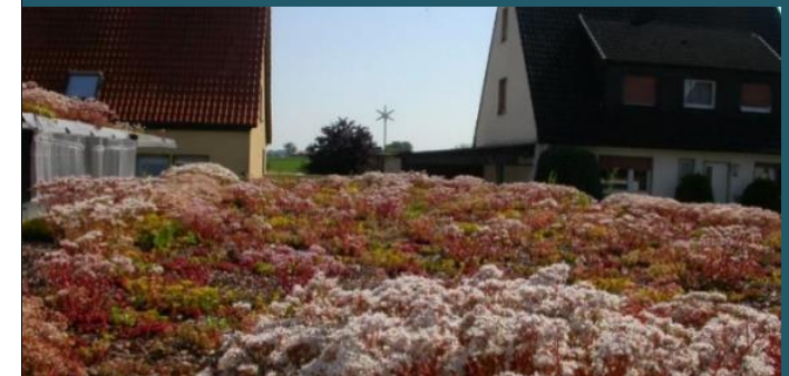
Extensive Dachbegrünung (Foto: B. Spengler, Emschergenossenschaft)
